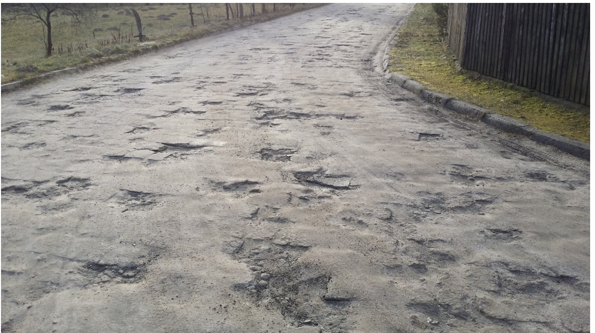
4. Ul. Zwycięstwa. Końcowy odcinek ulicy o zmniejszonej szerokości jezdni.
